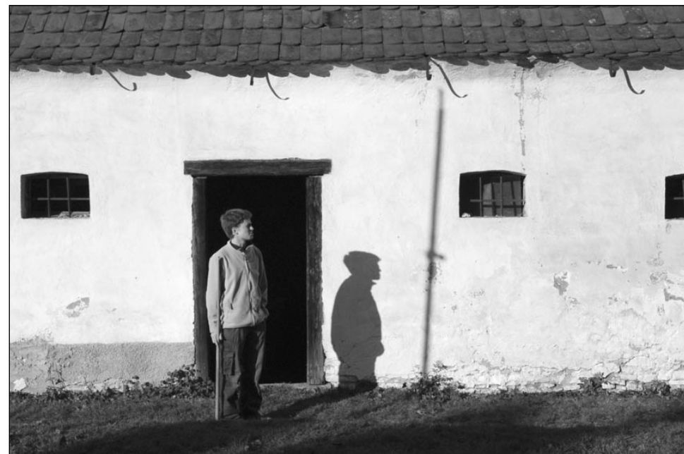
Vávra se na chvíli vzdálil od kulečnicku, aby obhlédl stavbu střechy
